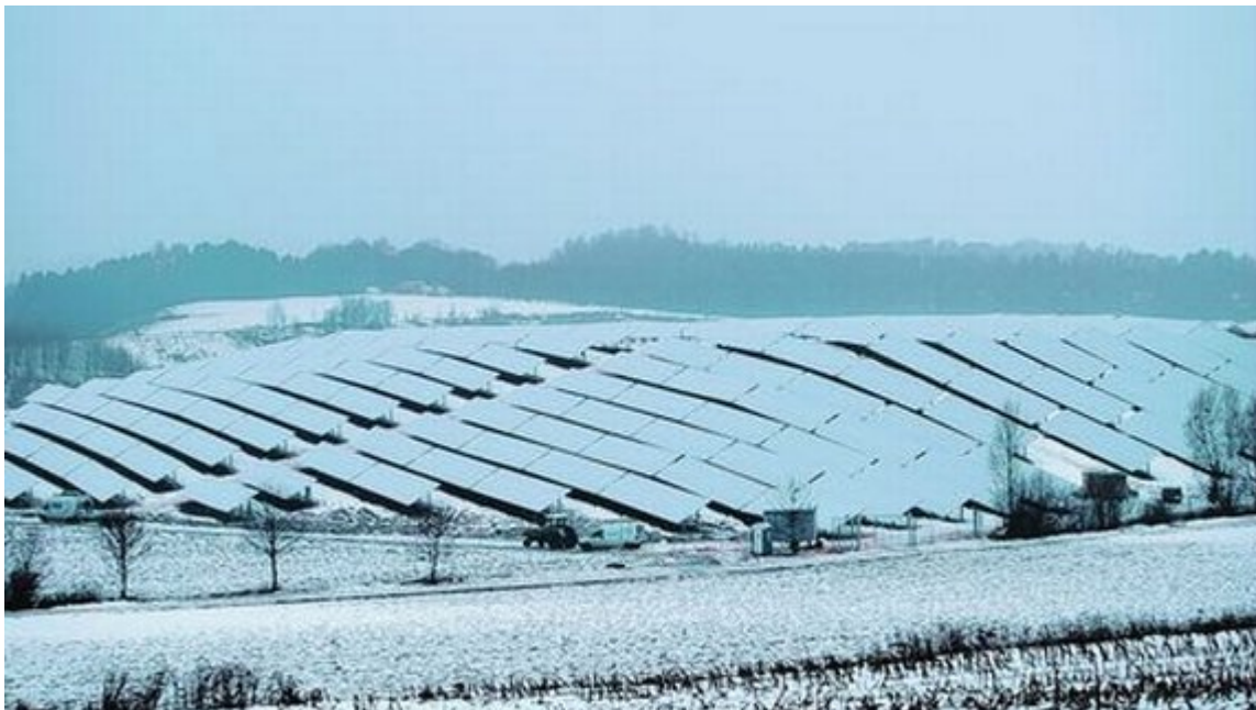
Der erste Solarpark des Landkreises eröffnet
